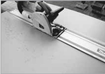
**Schneiden Sie die Platten mit den geeigneten Werkzeugen zu** und prüfen Sie die Passgenauigkeit zuerst ohne Kleber. Berücksichtigen Sie beim Zuschnitt, dass Sie einen Abstand von 3 mm zu allen festen Teilen, wie z.B. Brausetasse, Decke, Anschlüsse etc. einhalten. Nach dem fertigen Zuschnitt brechen Sie die Kanten mit einer feinen Feile oder einem Schleifpapier (Körnung ca. 100 – 150).
