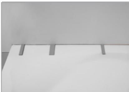
**Bringen Sie die Platte in Position** und kontrollieren Sie den 3 mm Abstand zu allen festen Teilen. Danach drücken Sie die Platte gleichmäßig an.
